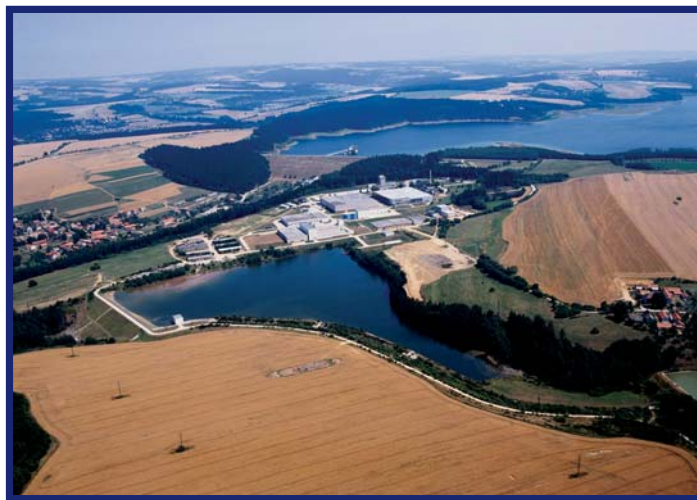
Úpravna vody Želivka a vodní nádrž Švihov (zdroj https://www.pvk.cz/o-spolecnosti/fotogalerie-spolecnost/uv-zelivka/ )
