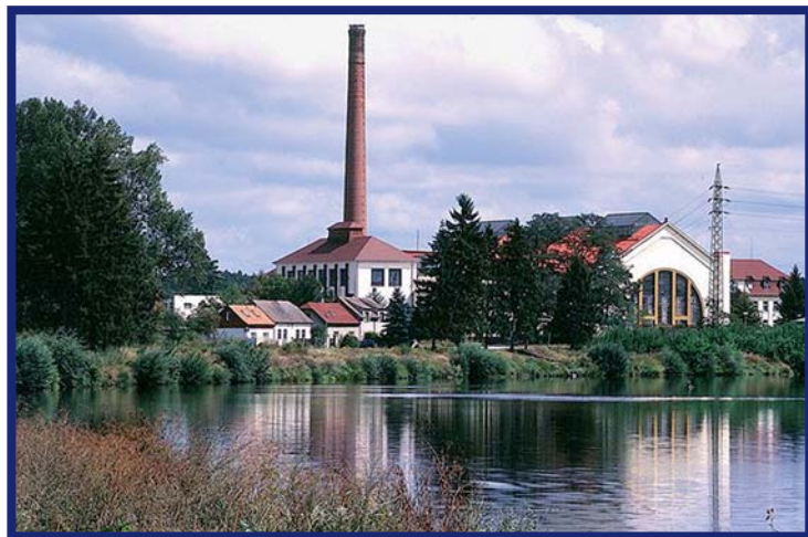
Úpravna vody Káraný (zdroj https://www.metro.cz/vodarna-v-karanem-dodava-prazanum-vodu-uz-cele-stoleti-p1j-/praha.aspx?c=A131231_101621_co-se-deje_rab )
