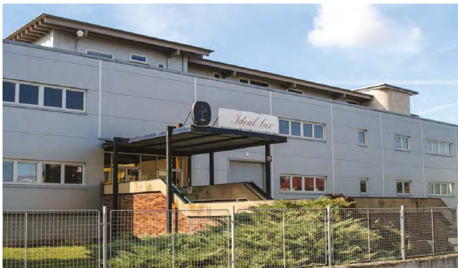
Nástavba ve třetím patře bude zbourána. Místo ní vznikne samostatné třetí patro.
