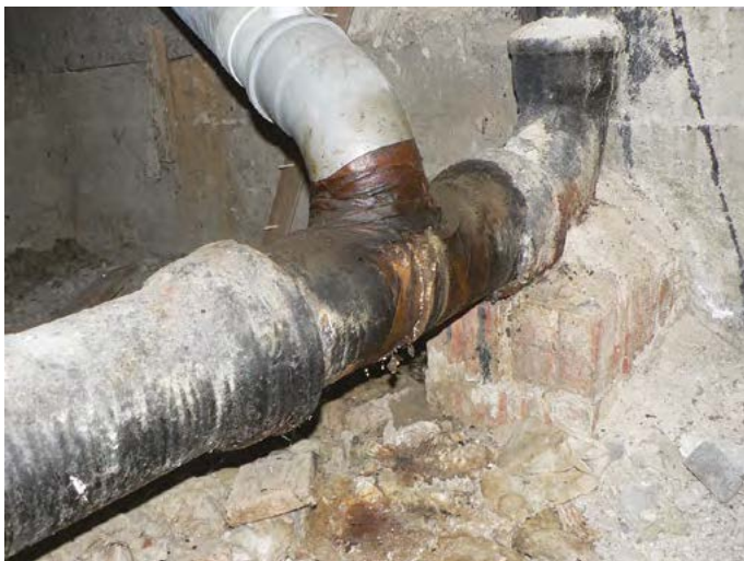
Původní napojení kanalizace.
