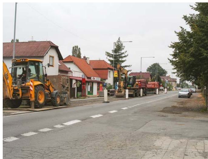
Na jaře by měla být dokončena stavba kanalizace na hlavní.
