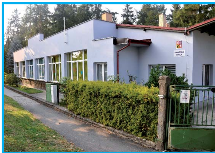
Budova MŠ Pražská
